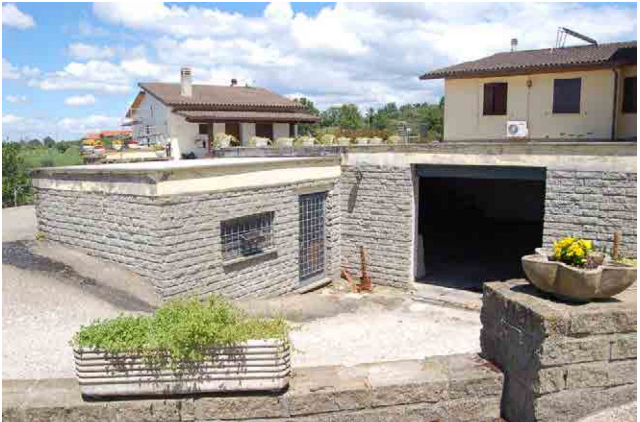
Foto 9 – Vista ingresso pedonale e carrabile al garage
