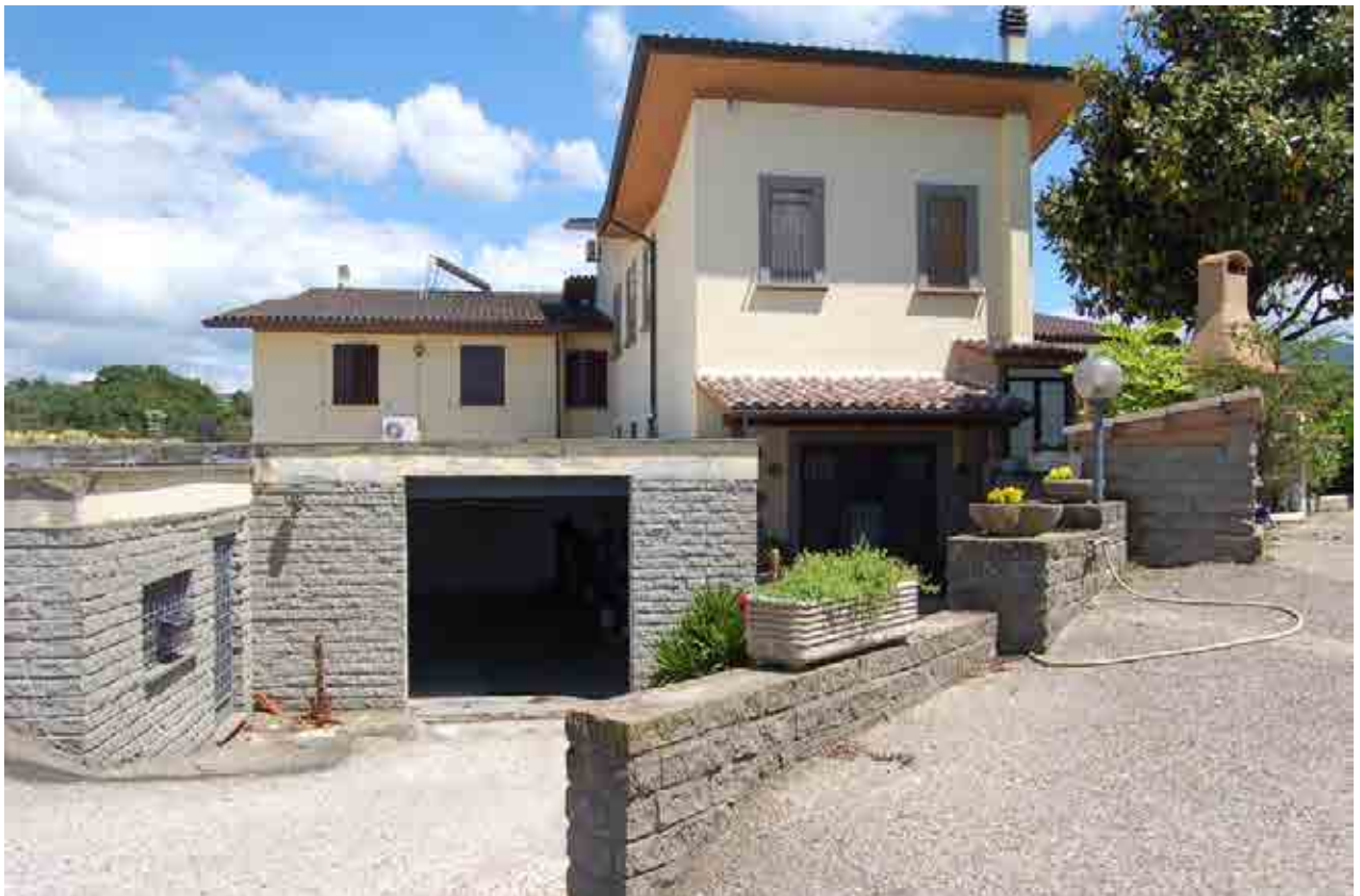
Foto 14 – Ingresso alla taverna
