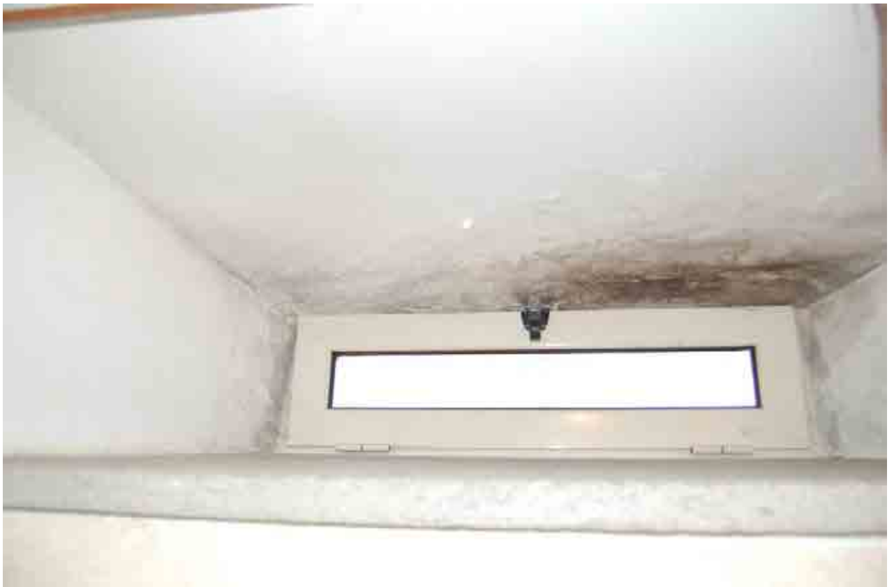
Foto 22 – Finestra locale bagno
