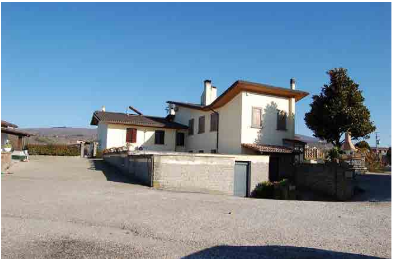
Foto 6 - villino bifamiliare fronte sud-ovest
