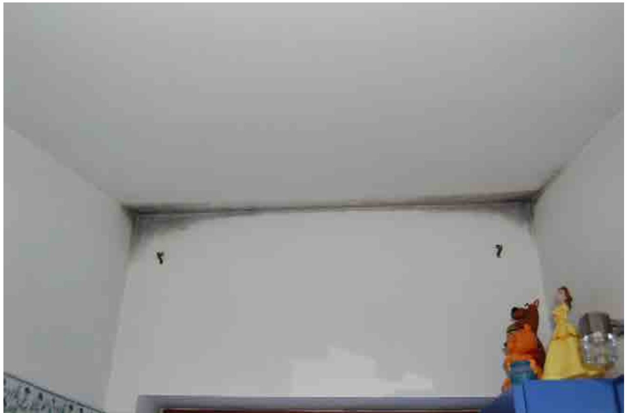
Foto 40 – dettaglio solaio bagno privato della camera su soppalco
