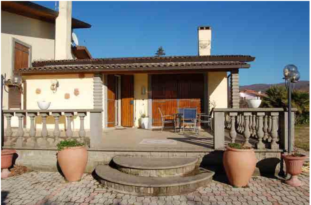
Foto 5 – Dettaglio Ingresso (fg. 257, part. 984)
