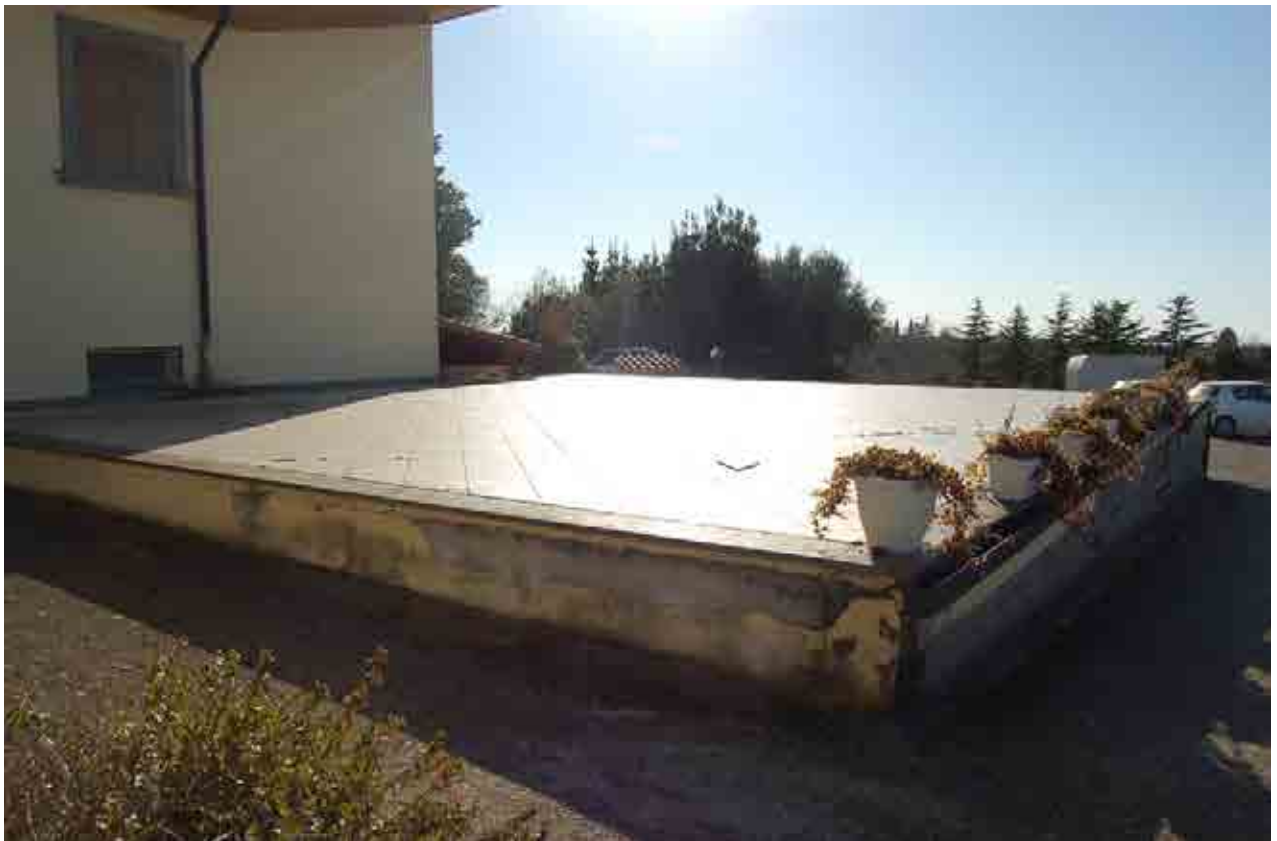
Foto 8 – Dettaglio copertura piana locale adibito a garage (fg.257, part.977)
