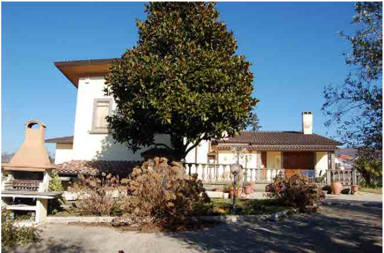
Foto 4 - villino bifamiliare fronte sud
